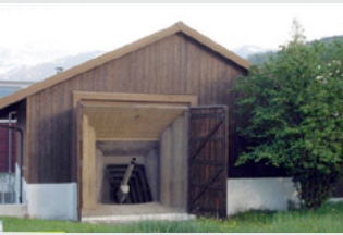
Artilleriewerk Faulensee Faulensee
